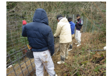
防護柵の設置
